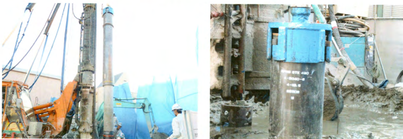
建て込み時の状況
